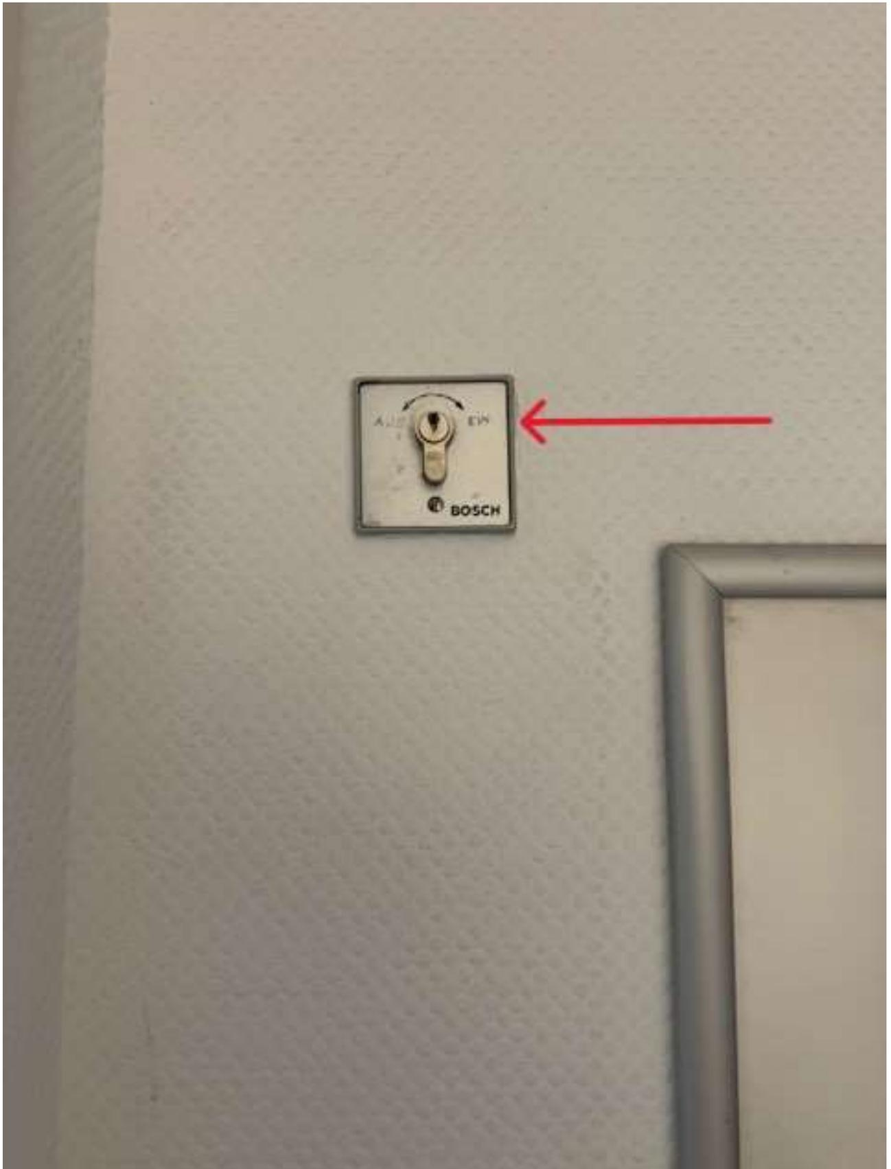
Schlüsselschalter auf Ein drehen und Schlüssel wieder in Mittelstellung zum Abziehen zum Ausschalten auf Aus drehen.
